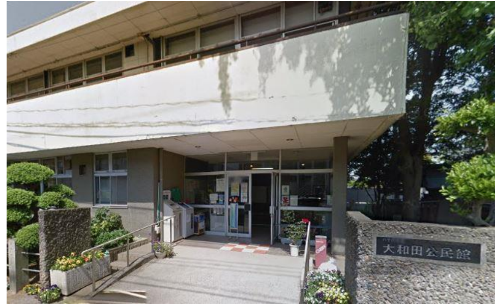
旧大和田公民館（昭和51年度建設）
