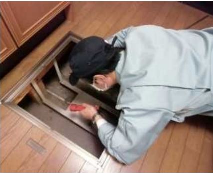
「土台・床組、基礎」調査の様子
