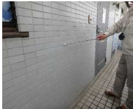
「外部（外壁）」調査の様子
