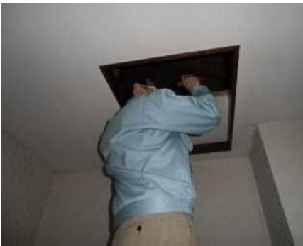
「小屋組・梁」調査の様子
