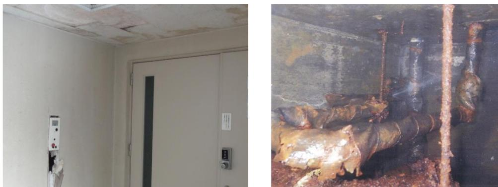
図 2 老朽化の現状(左:雨漏り跡, 右:老朽化した配管)
