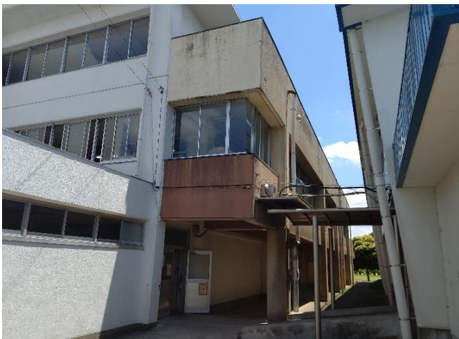
校舎5 (体育館側)
