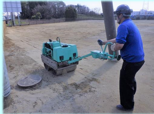
地盤の強度が満たされるように厚さ30cm毎に重機等で転圧し締め固める
