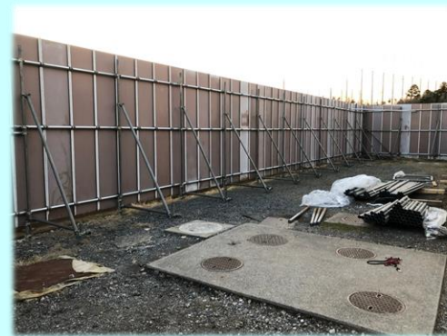
近年の異常気象に備え 単管を十分に打込み補強
