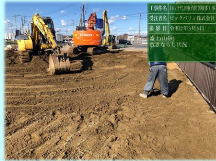
重機で施工できない狭所は手作業で敷きならす
