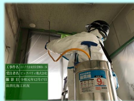
除去する建材を薬液等で湿潤化
