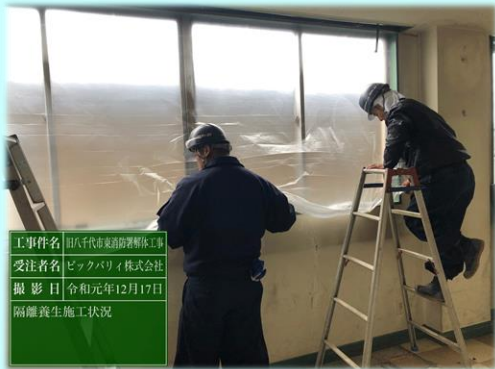
石綿除去作業内をプラスチックシート等で隔離 ※除去する建材と除去方法により異なる
