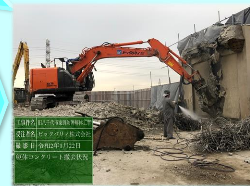
上階から1層ごとに圧砕工法で解体
