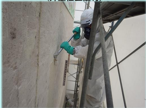
手工具ケレン工法による除去
