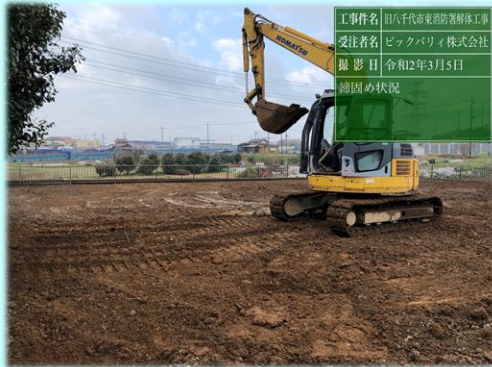
地盤の強度が満たされるように厚さ30cm毎に重機等で転圧し締め固める
