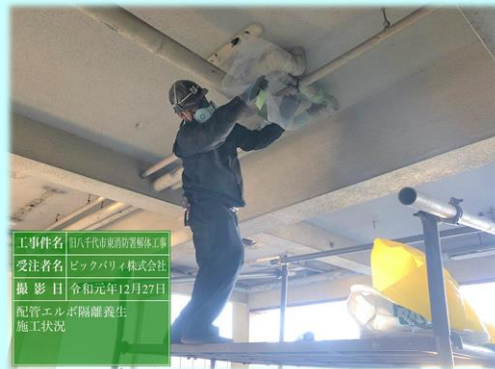
石綿除去作業内をプラスチックシート等で隔離 ※除去する建材と除去方法により異なる
