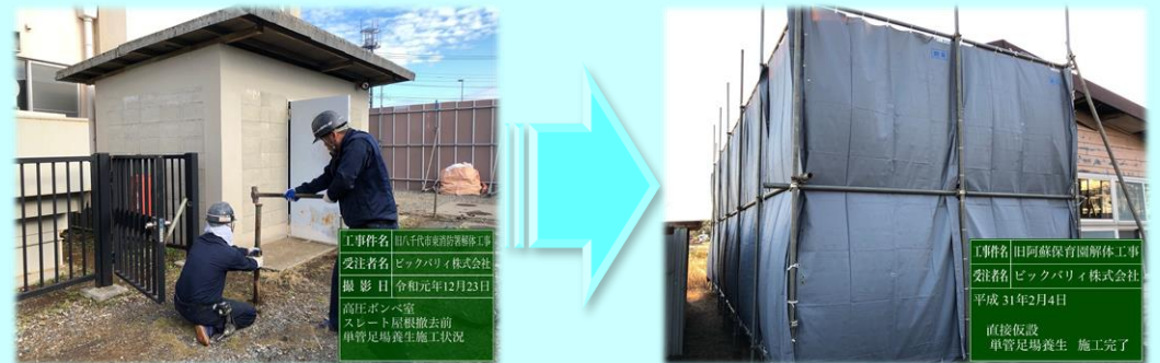
【単管足場+防音シート】
