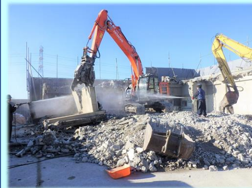
上階から1層ごとに圧砕工法で解体
