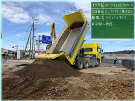
大型車で埋戻し材を搬入
