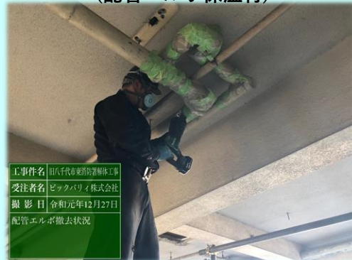
石綿を使用していない箇所での切断
