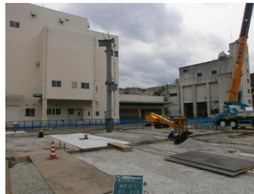
鉄骨柱建込み
