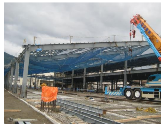
鉄骨梁建込み
