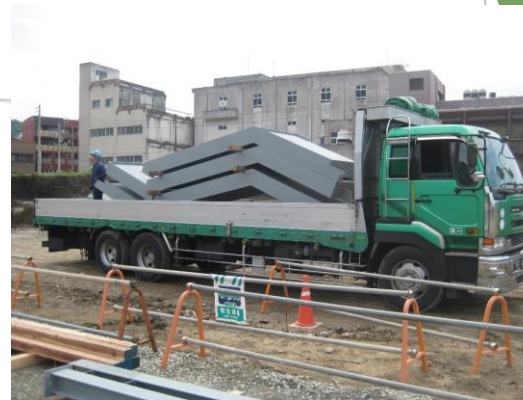
鉄骨材料搬入
