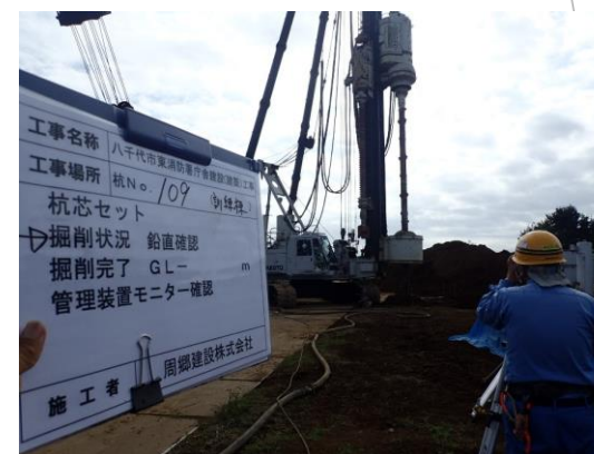
杭打込み箇所掘削
