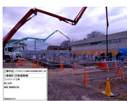
(コンクリート工事)
