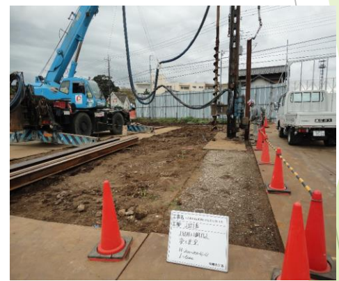
山留材打込①
