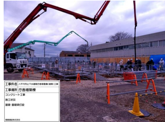
基礎コンクリート打設
