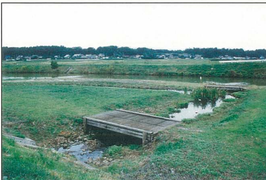
①⑧-1 桑納川浄化施設に併設する親水公園
