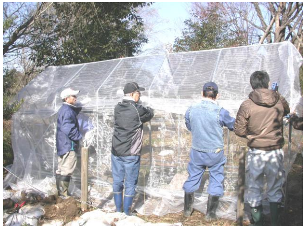
(実験水路のハウス設置作業)
