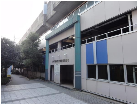
八千代緑が丘自転車駐車場
