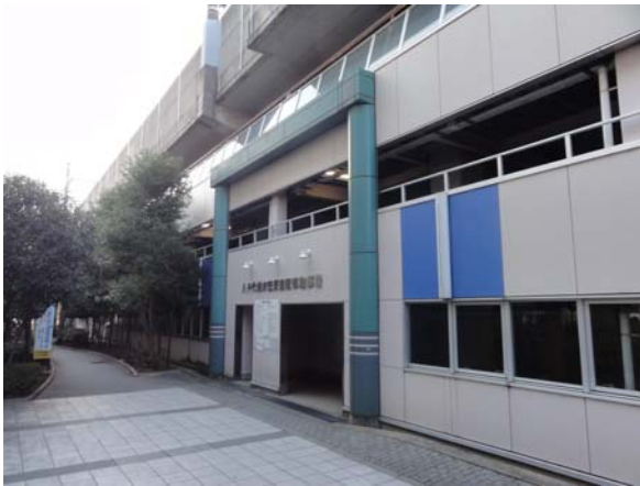
八千代緑が丘自転車駐車場
