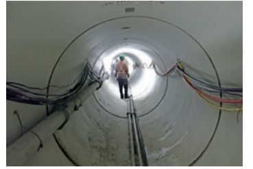
▲施工中の流下型貯留管の内部
