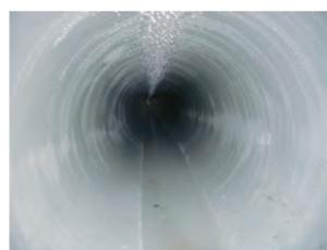
▲改築後：更生工法により改築した下水道管
