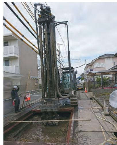
▲大和田南小学校に造った調整池(令和元年度に完成)へ流入する雨水管の布設工事の様子
