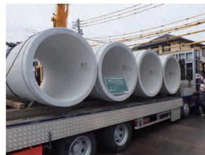
▲上高野地区で実施している布設工事で使用する雨水管
