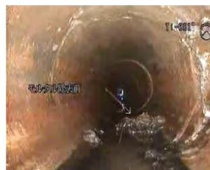
▲改築前：老朽化が進み、亀裂が発生している下水道管
