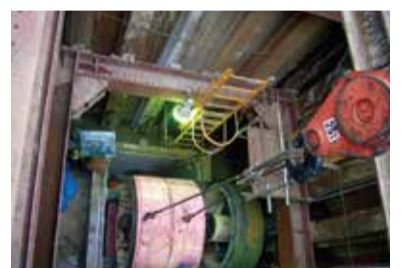
▲シールド工法による大和田新田地区浸水対策管渠整備工事(平成28年)
