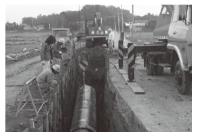
▲下水道管布設工事の様子(昭和50年)
