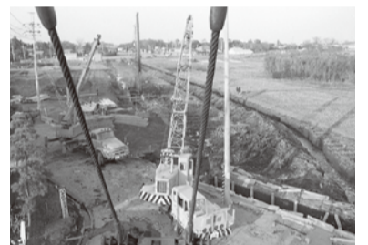
▲八千代都市下水路整備工事の様子(昭和47年)
