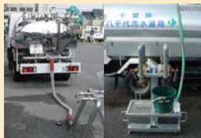
▲給水車による給水
