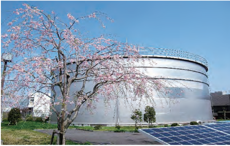
▲萱田浄水場ステンレス製配水池
