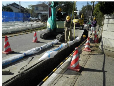
▲耐震管の布設工事の様子
