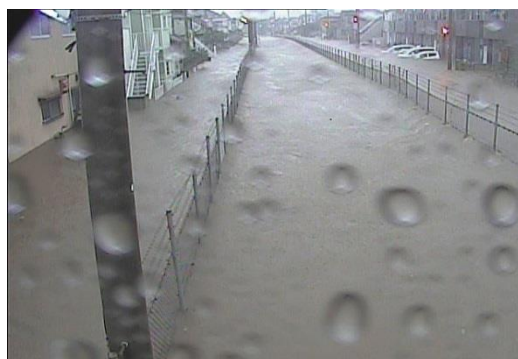
▲平成 25 年 10 月に発生した台風 26 号時の八千代 1 号幹線の様子
