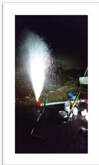
図 5-13 管路洗浄の風景
