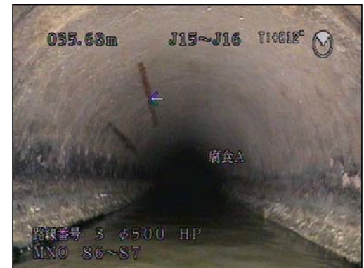
汚水管内部状況(テレビカメラ調査) ← : 撮影位置
