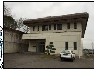
北部污水中継ポンプ場
