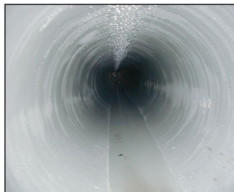
施工後：更生工法により改築した下水道管（内部）
