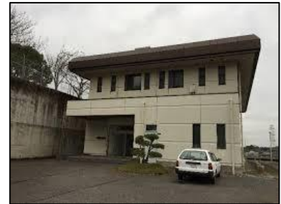
北部汚水中継ポンプ場
