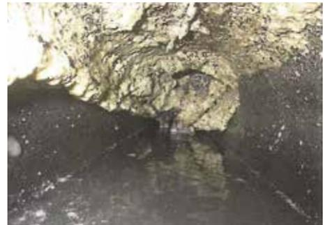
▲油が冷えて固まり下水道(汚水管)上部に付着している様子
