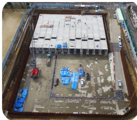
▲大和田南小学校の校庭の地下に、大きな調整池 つく を造る工事の様子
