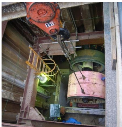
▶ シールド工法（地下にトンネルを掘って、管を入れる方法）による、雨水管工事の様子
