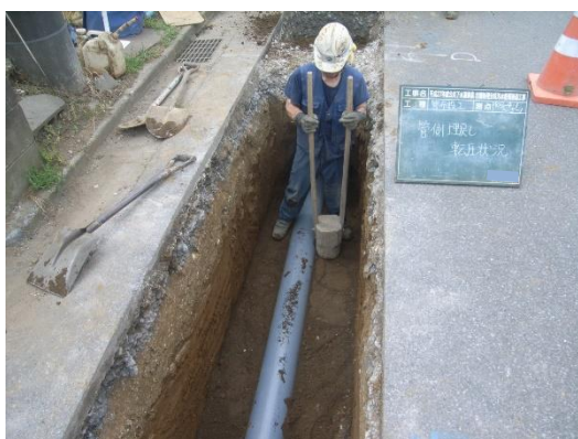
▲下水道管を入れる工事の様子
