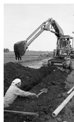
▲水道管の整備工事
