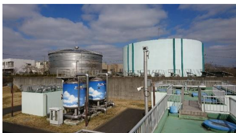
▲萱田浄水場の配水池
