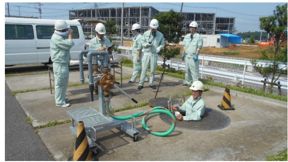
▲緊急用貯水槽がある西八千代調理場の敷地内で、給水作業の流れを確認
