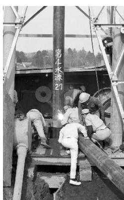
▲井戸を掘る工事
