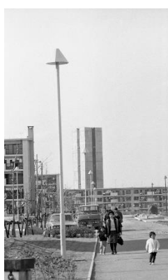
▲米本団地と、その後ろの米本浄水場の高架水槽
