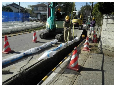
▲水道管を取りかえる工事の様子
