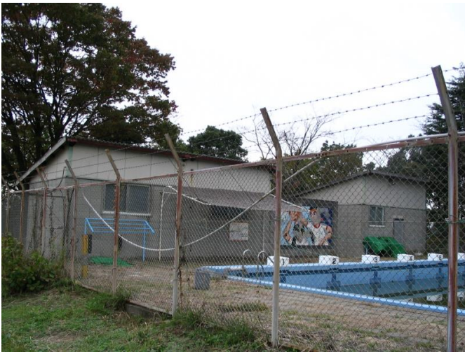
プール更衣室棟
