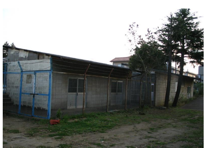
プール更衣室棟
