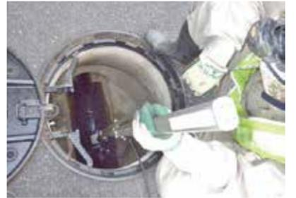
マンホール内に専用のカメラを差し込み、管渠内部の劣化状況を調査(撮影)しています。
