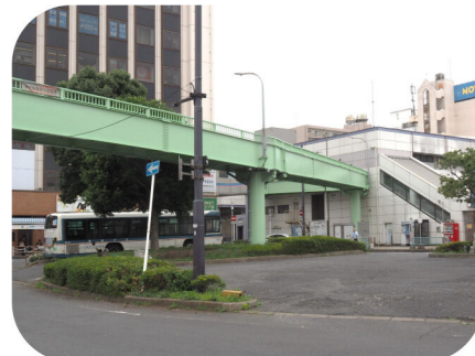
八千代台駅西口駅前広場
