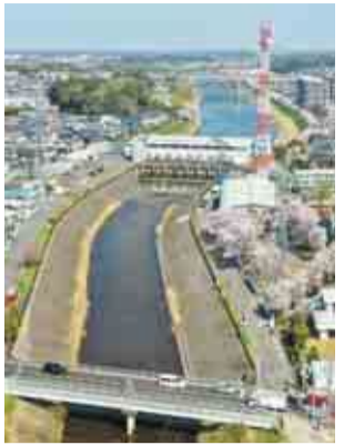
▲赤白鉄塔が印象的な大和田機場
