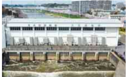
▲ポンプ試運転の様子
