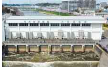
▲ポンプ試運転の様子
