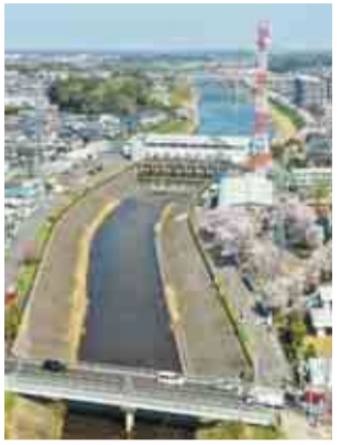
▲赤白鉄塔が印象的な大和田機場
