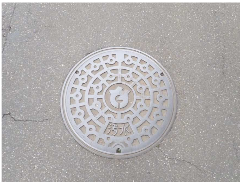
45 マンホール (汚水)
