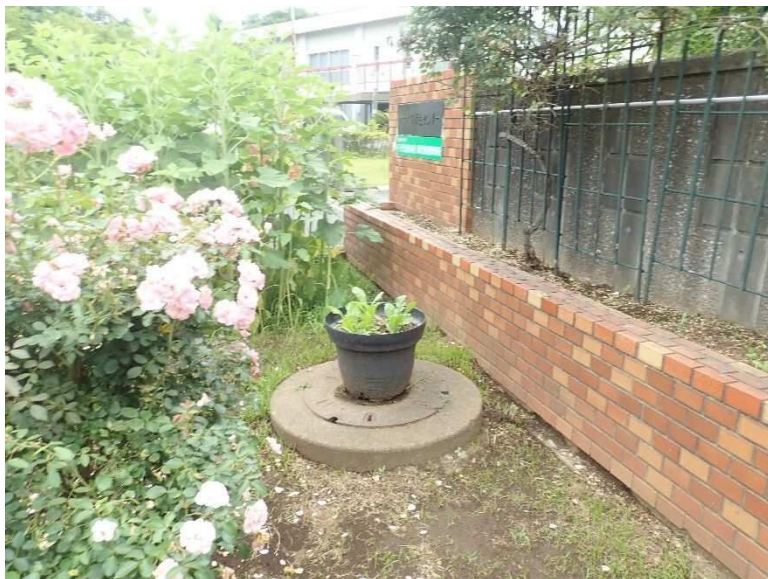
33 マンホール（雨水）
