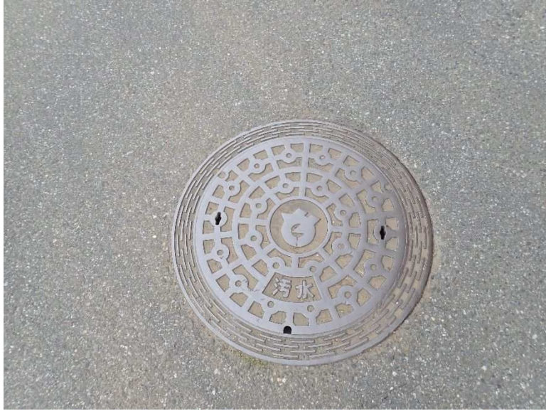
61 マンホール（汚水）
