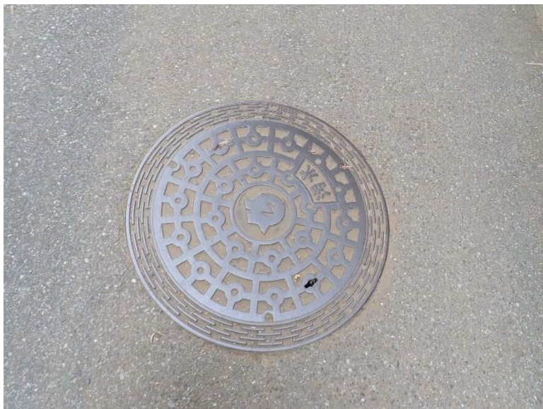
57 マンホール（汚水）
