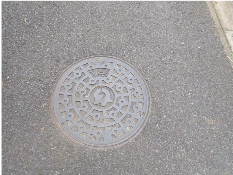
32 マンホール（汚水）
