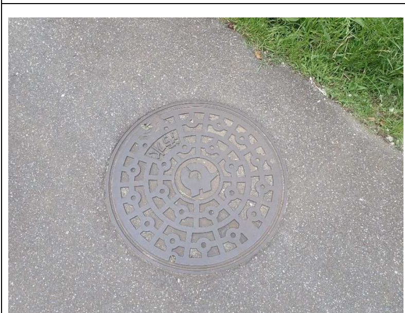
29 マンホール（汚水）
