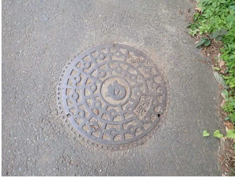
55 マンホール（汚水）
