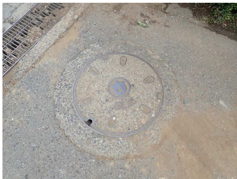
11 マンホール（雨水）
