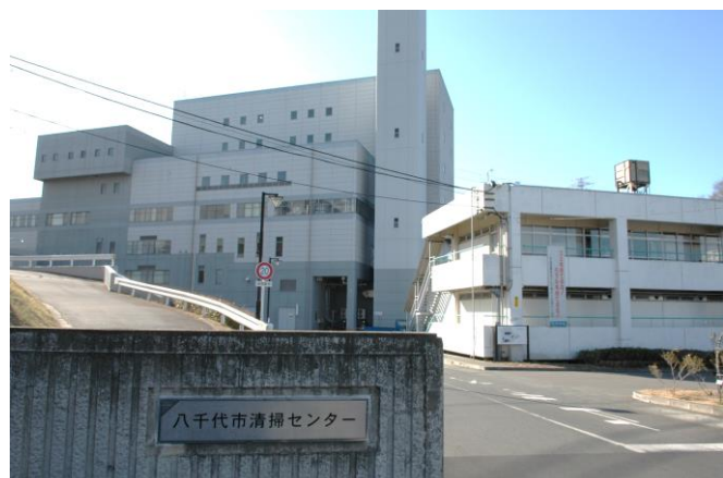
八千代市清掃センター 出典：八千代市
