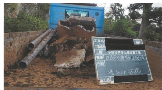
(7)全撤去又は一部撤去した場合にあっては、 撤去した既存くみ取便所を車両に積載 したことがわかる写真
