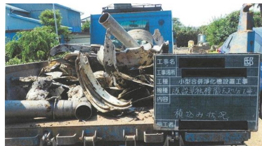
(7)全撤去又は一部撤去した場合にあっては、 撤去した既存単独処理浄化槽を車両に積載 したことがわかる写真
