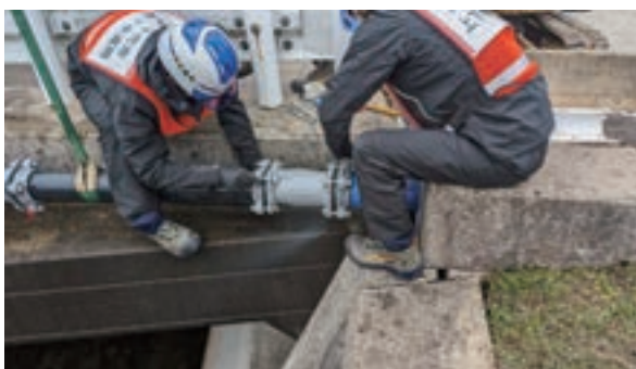
橋に添架されている水道管の修繕状況
