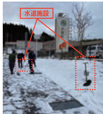
積雪の中で水道施設を探す職員
