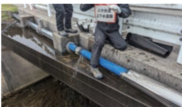
橋に添架されている水道管の修繕状況
