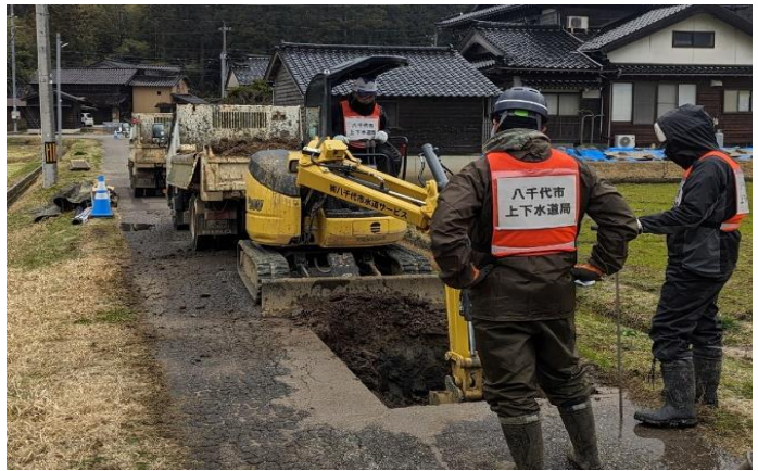
配水管・給水管の修繕
