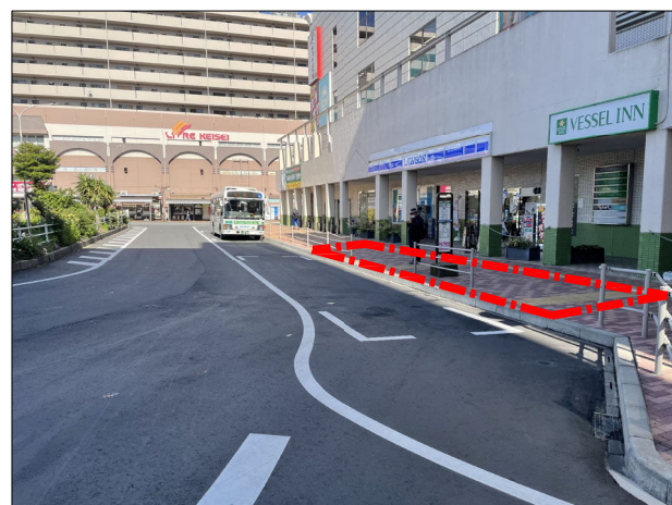
現況写真 ①
