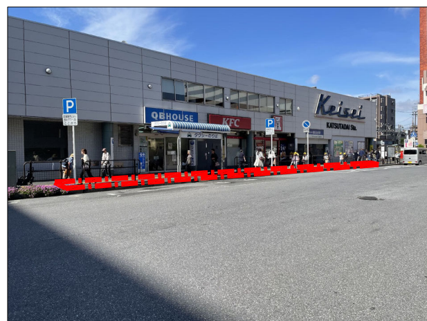
現況写真 ①
