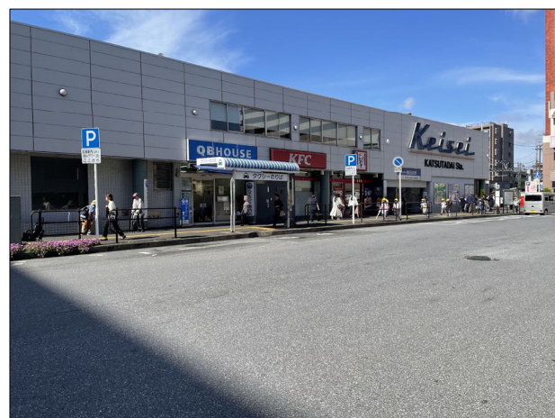
現況写真 ①
