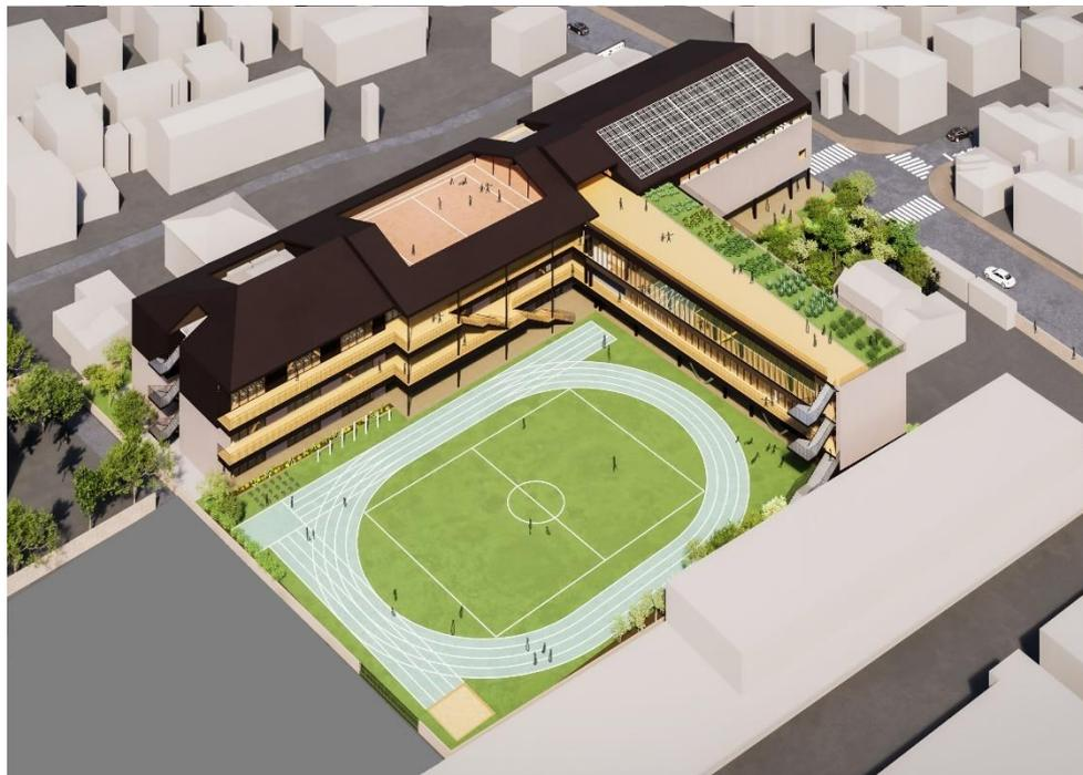
構造・階層：鉄骨造・3階建て
