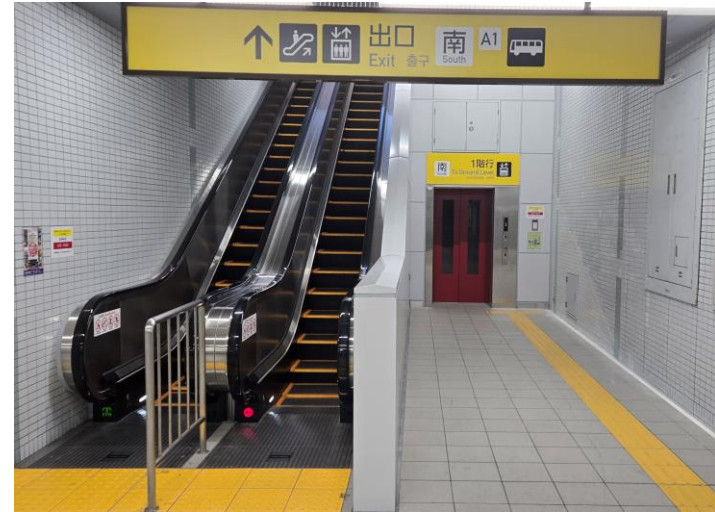
勝田台南口エスカレーター（一人乗り2基）
