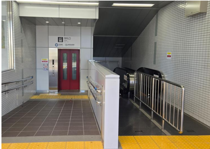
勝田台南口エレベーター（1基）
