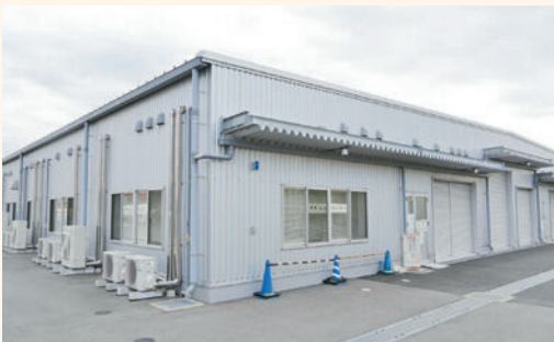
▲写真の建物に消費生活センターがあります
