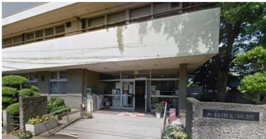
旧大和田公民館(昭和51年度建設)
