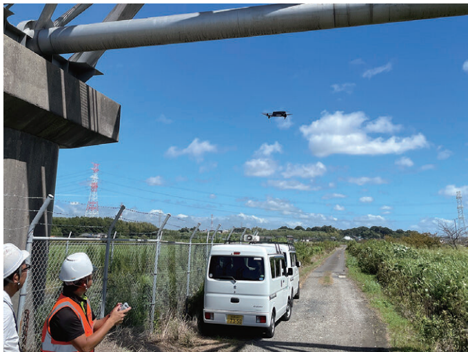
ドローンでの空中撮影の様子
