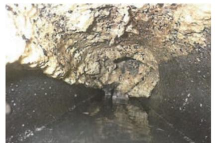
▲油が冷えて固まり下水道(污水管)上部に付着している様子
