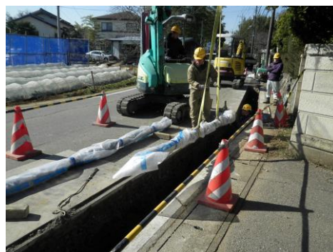
▲耐震管の布設工事の様子
