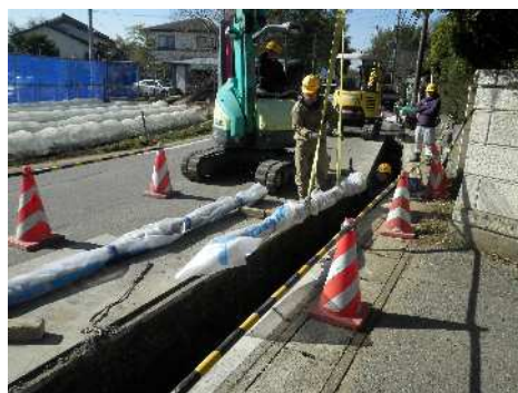
▲耐震管の布設工事の様子
