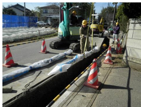
▲耐震管の布設工事の様子
