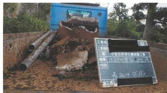
(7)全撤去又は一部撤去した場合にあっては、 撤去した既存くみ取便所を車両に積載 したことがわかる写真
