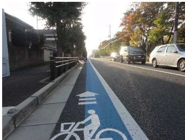
ブルーレーン表示例（船橋市）
