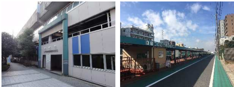
八千代緑が丘自転車駐車場
