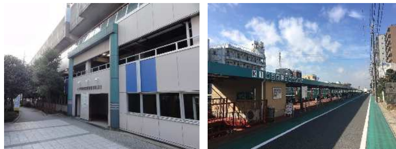
八千代緑が丘自転車駐車場
