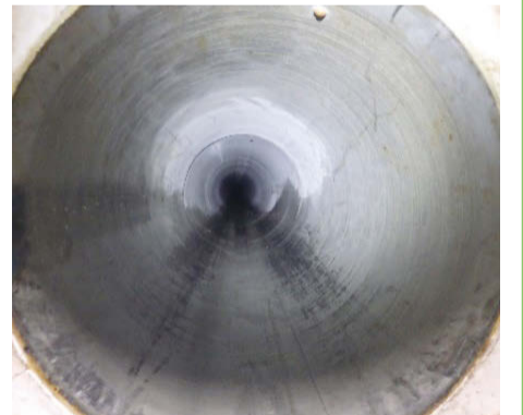
完成した雨水管
