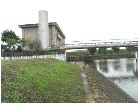
排水機場の法面での生育状況
