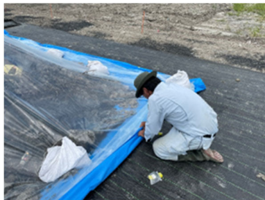
② 盛土の被覆と密閉
