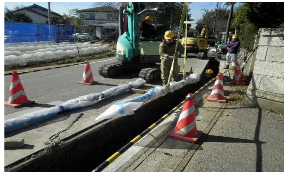
▲耐震管の布設工事
