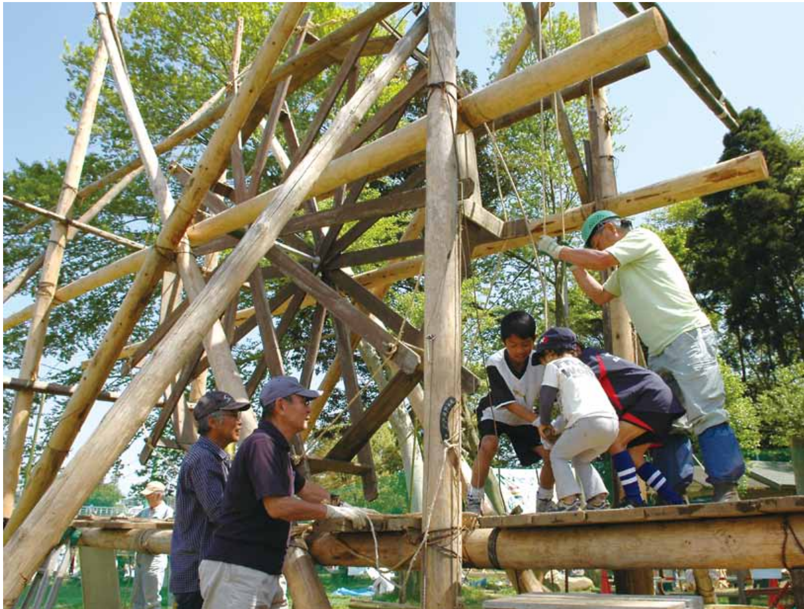
▲丸太で組んだやぐらの上で竹ひごを上下に動かし、地面を掘り進めます
